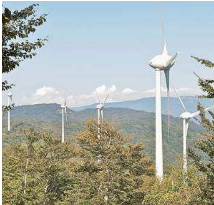
Il parco Eolico "Valbormida" a Montenotte: sarà inaugurato domani
